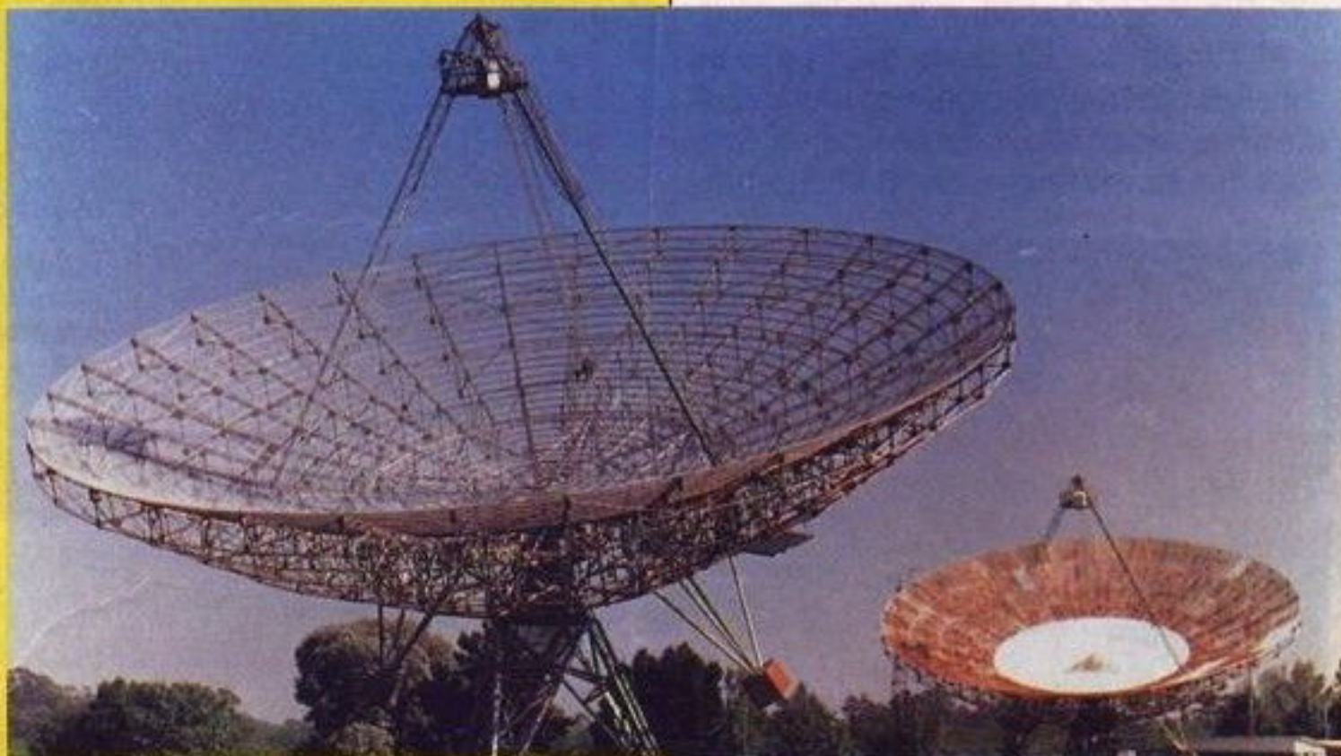
Antenas parabólicas de 30 metros de diámetro operando en captaciones sobre galaxias externas y la Vía Láctea a distancias de millones de años de luz. Estas antenas fueron construidas en el IAR, donde operan en longitud de onda de 18 y 21 cm. La primera en la foto será destinada al proyecto META.
