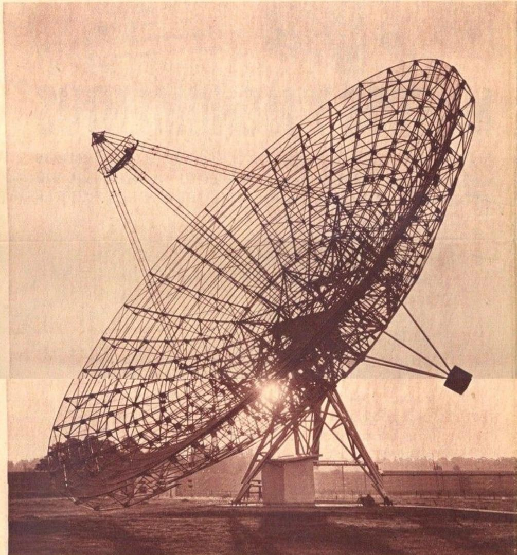
El espejo parabólico de Pereyra, con su antena dipol en el extremo superior izquierdo de la fotografía, visto desde el este. El instrumento está diseñado para detectar ondas de radio en la longitud de 21 centímetros a fin de estudiar la distribución del hidrógeno en nuestra galaxia
