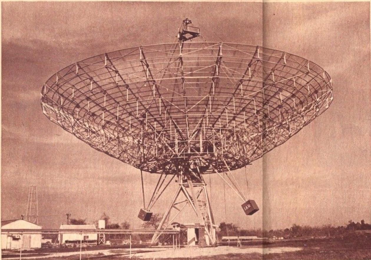
La antena en su posición neutral, apuntando hacia el cenit. Mediante motores eléctricos se mueve 60 grados en ascensión recta, y 81 grados en declinación. Uno de dichos motores la hace girar tan despacio como se requiere, que en 24 horas completaría un giro completo sobre su eje vertical
