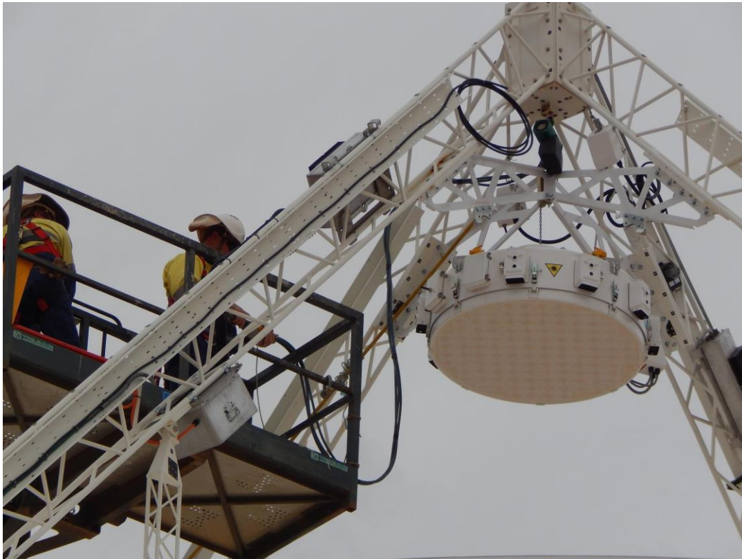
Figura 3: detalle de un Phase Array Feed (o PAF), durante su colocación. Crédito: CSIRO.
