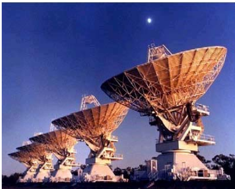
Figura 8: La foto muestra 5 de los 6 radiotelescopios de 22 m de diámetro del Australia Telescope Compact Array (ATCA), en Narrabri, NSW, Australia. A una dada frecuencia, la mayor resolución angular se alcanza cuando la máxima separación entre discos es de 6 km. A 90 GHz, la resolución angular es de décimas de segundo de arco (fuente: D. Malin y CSIRO).
